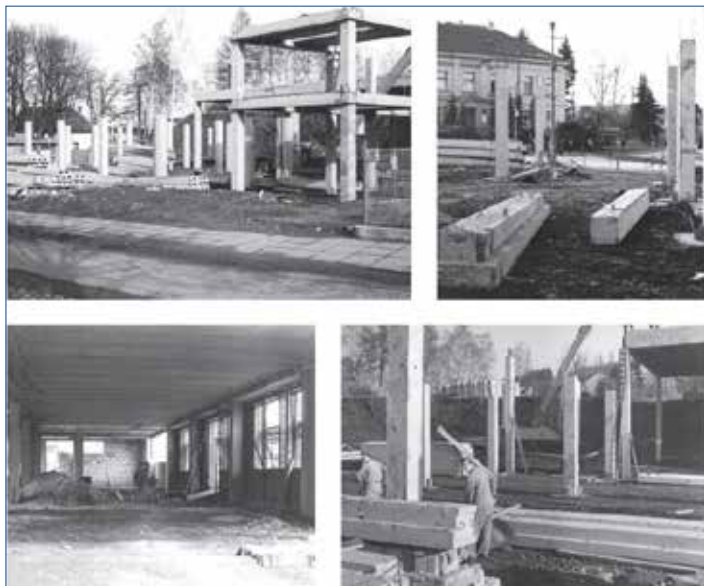
» Archivní fotografie z výstavby kulturního domu v Komárově
